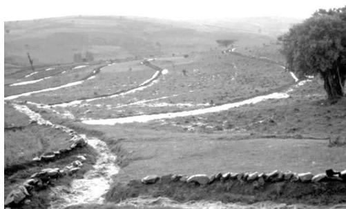
Patamar inclinado e vala com canais de drenagem. A água em excesso precisa de ser drenada e conduzida sem causar estragos. Anjeni, Ethiopia.. (Foto: Hans Hurni)
